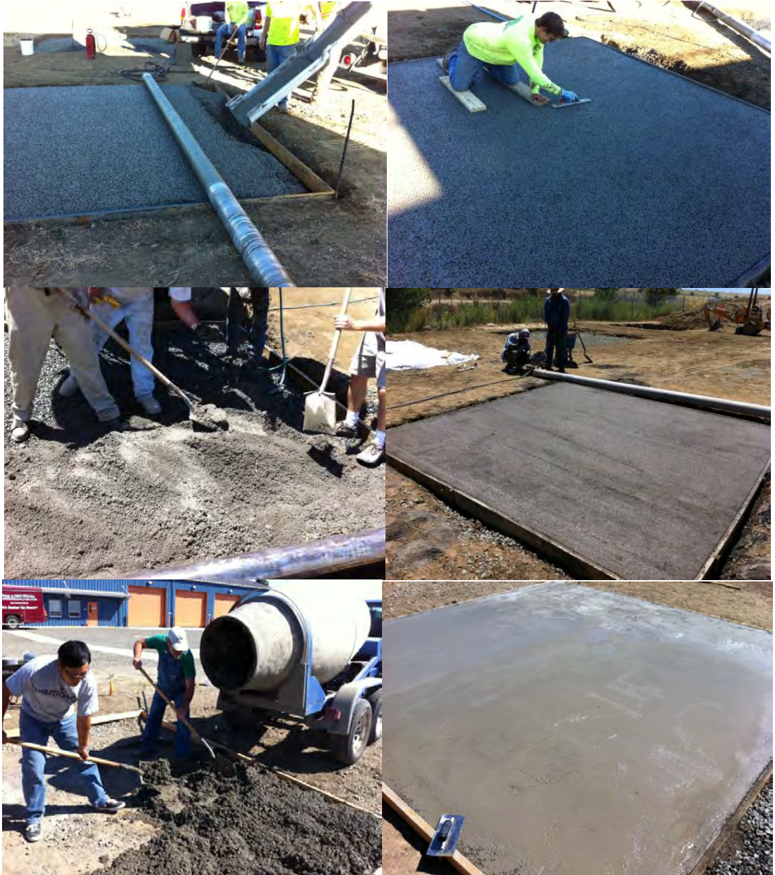
(d) Construction of surface layers (concrete pavements).
