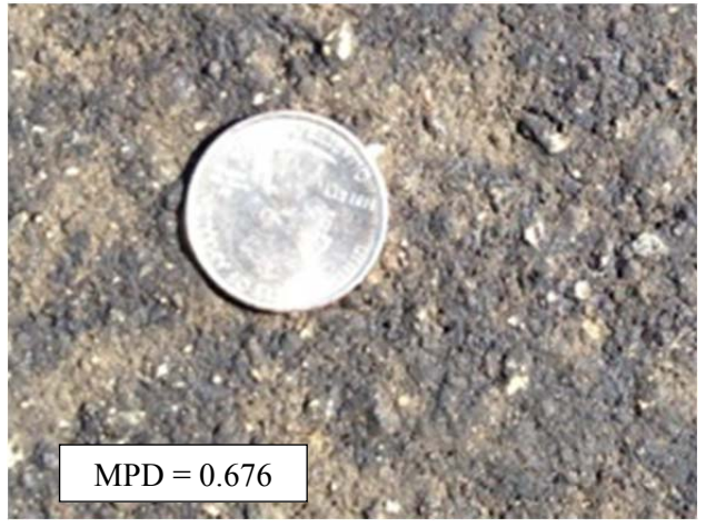
#8 Slurry seal (PM 9.6-9.4)
